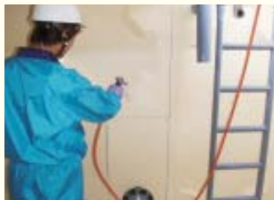
貯水槽清掃作業
