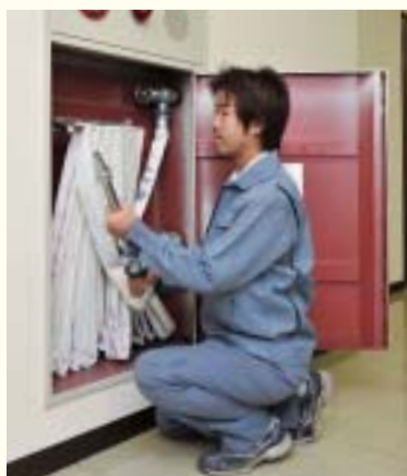
消防設備点検
